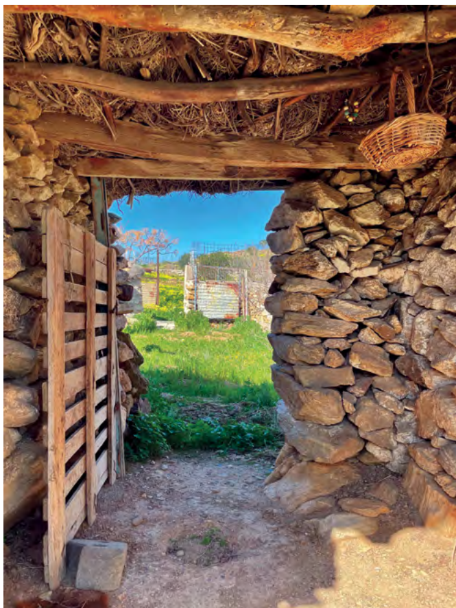
Το στενό πέρασμα του μητάτου. Στο έδαφος υπάρχει κυκλική εσοχή, σημείο τοποθέτησης του αρμεγού.
