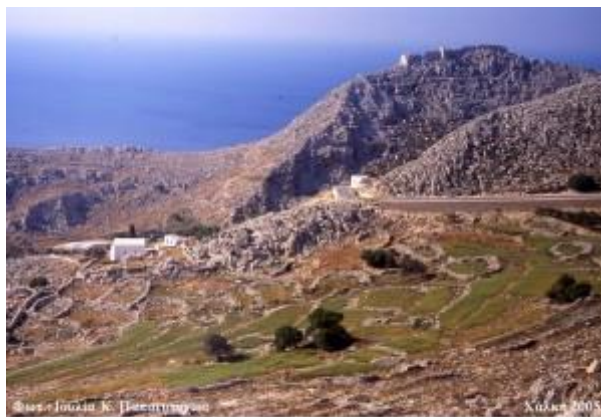
Αναβαθμιζόμενο τοπίο στη Χάλαη, το οποίο συγκροτείται από ποικίλες ξερολιθικές κατασκευές: τοίχους αντιστήριξης, τέν αναβαθμιζόν, κυκλικές περιφράξεις και οδούς.
