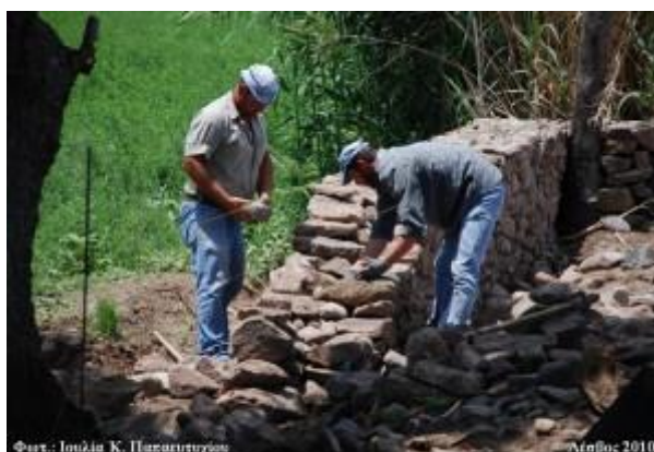
Φωτ.: Ιουλιάνη Κ. Παπαευτυχίου Λεσβός 2010 Κατασκευή ψηφιδωτού τοίχου περιφράξης από ξηρόλιθα, για την αρμόδιση ελαιοκτησιών στην οπαιήρο της Λεσβού.
