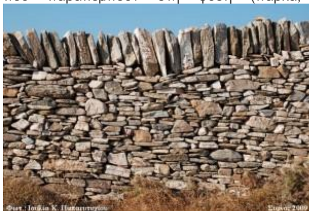
Φωτ.: Ιουλιάνη Κ. Παπαγιαννίδου Στιγμή 2009 Τοίχος από ξερολιθιά σε άριστη κατάσταση, για την οριοθέτηση κτήσεων στην οπαύθη της Σίφνου. Οι όρθιες σχιστοπέλικες αποτρέπουν τη διάλυση των ζωνών.
