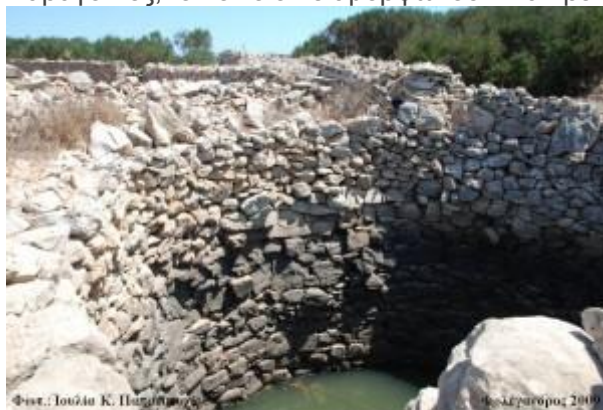
Φωτ.: Ιουάνη Κ. Παπαδοπούλου Πηγάδι μεγάλων διαστάσεων από Ξερολιθική, για το ποτισμα των ζώων και την άρδευση των παρακείμενων καλλιεργειών, στην υπαίθρο της Φολέγανδρου.
