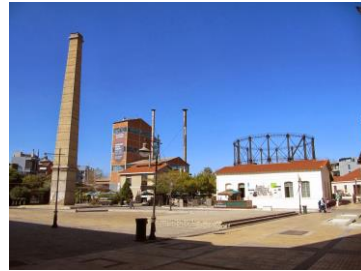
5. Εργοστάσιο Φωταερίου Γκάζι
