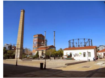
5. Εργοστάσιο Φωταερίου Γκάζι
