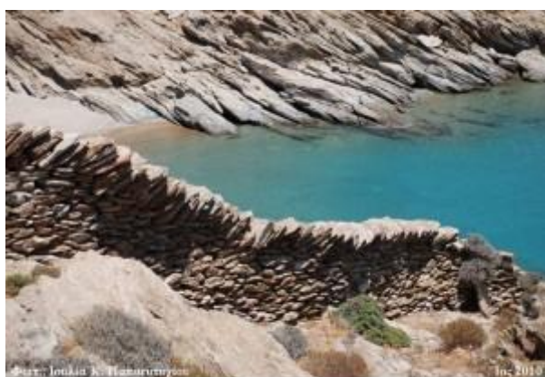
Φωτ.: Ιουλία Κ. Παπαγιαννού Ιού 2019 Διαχωριστικός τοίχος από ξερολιθιά σε άριστη κατάσταση, για την οριοθέτηση ενοικησιών σε παραθαλάσσια περιοχή της Ιού. Οι όρθιες σχιστοπέλικες αποτρέπουν τη διάβρωση των ζωνών.
