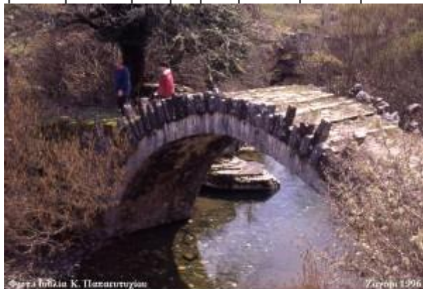
Τεφίρι στο Ζάγορι, με σπήλαιο από ξερολιθιά και λιθοστρωτή επιχώμαση για τη δύσκολη αν- θρώπινη και ζώον.
