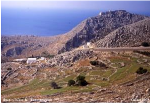
Αναβαθμισμένο τοπίο στη Χάλαση, το οποίο συγκροτείται από ποικίλες ξερολιθικές κατασκευές: τοίχους αντιστήριξης, τέν αναβαθμίσεων, κυκλικές παραφράξεις και οδούς.
