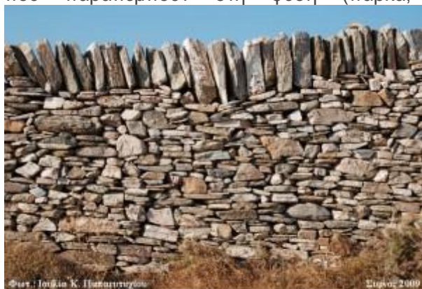
Φωτ.: Ιουλία Κ. Παπαγιαννού Στις 2009 Τοίχος από ξερολιθιά σε άριστη κατάσταση, για την οριοθέτηση ενοικησιών στην οπαύθη της Σέρνου. Οι όρθιες σχιστοπέλικες αποτρέπουν τη διάβρωση των ζωνών.
