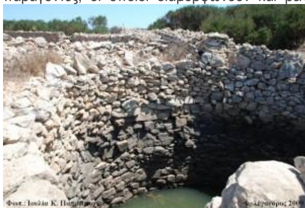
Φωτ. Ιουλίμ Κ. Παπαδόπουλος, Φεβρουάριος 2009 Πηγάδι μεγάλων διαστάσεων από Ξερολιθάς, για το ποτισμα των ζώων και την άρδευση του παρακείμενου καλλιμαργαίου, στην υπαίθρο της Φολέγανδρου.
