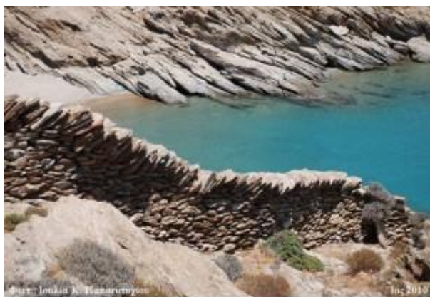
Φωτ.: Ιουλιάνη Κ. Παπαγιαννάκη Διαχωριστικός τοίχος από ξερολιθιά σε άρσιστη κατάσταση, για την οριοθέτηση οικοκτημάτων σε παραθαλάσσια περιοχή της Ιού. Οι όρθιες σχιστοπέλικες αποτρέπουν τη διάβρωση των ζώνων.
