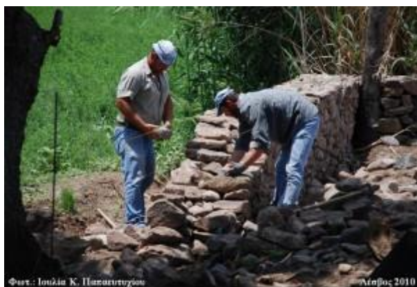
Φωτ.: Ιουλία Κ. Παπαγιαννάκη Κατασκευή γεφύριού τόξου περριούλης στο Ξερολίθιο, για την ασφαλέστερη είσοδο στην υπαίθρο της Λορέου.
