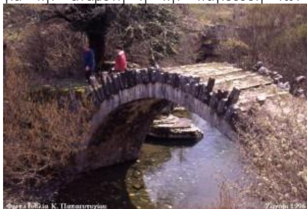
Φωτ. Γεώργιος Κ. Παπαγιαννής Γεφύρι στο Ζεγόρι, με σπήλαιο από ξερολιθιά και λιθοστρωτή επιχώμαση για τη δέσμευση αν- θρώπων και ζώων.
