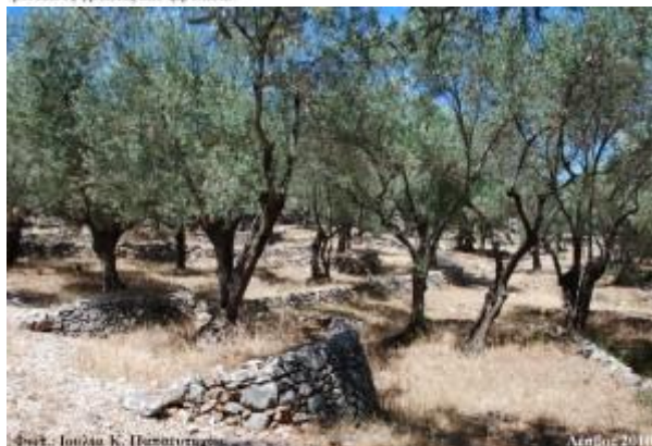
Φωτ.: Ιουλίττα Κ. Παπαγιαννίδη, Αθήνα 2010 Αντικατασκευασμένο τοίχο από ξερολίθια για τη διαμόρφωση αναβαθμίσεων σε ελαιώνα, στην οπισθή της Λέσβου.
