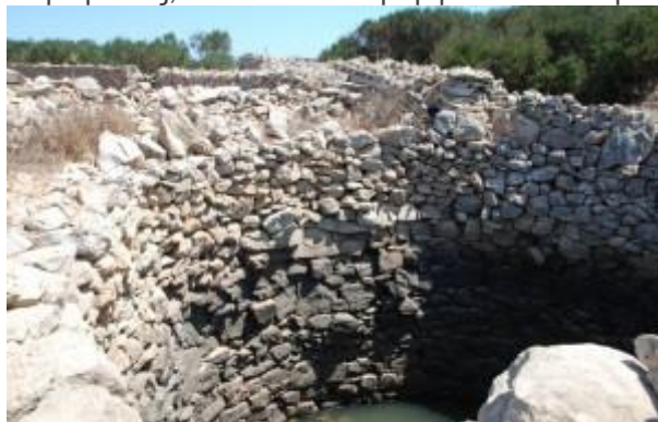
Φωτ.: Ιουλιάνη Κ. Παπαγιαννάκη Πηγάδι μεγάλων διαστάσεων από ξερολιθιά, για το ποτισμα των ζώων και την άρδευση των παρακείμενων καλλιέργειών, στην ύπαιθρο της Φολεψιάς.
