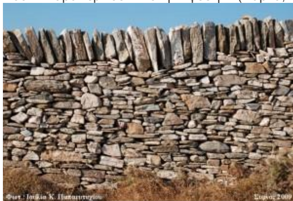
Φωτ.: Ιουλία Κ. Παπαγιαννάκη Τοίχος από Ξερολίθιο σε άριστη κατάσταση, για την ασφαλέστερη είσοδο στην υπαίθρο της Σίμων. Οι άρθρες οριστοπύλικες αποτρέπουν τη διάλυση των λίθων.
