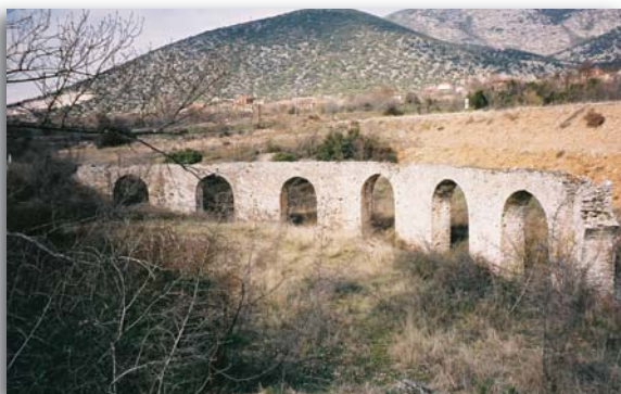
Εικ.09. Υδατογέφυρα στο Νικηφόρο Ξάνθης.
