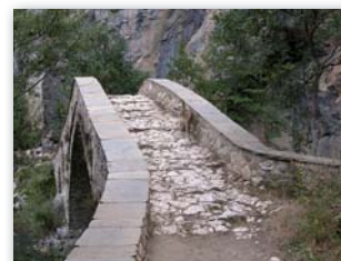
Σχέδιο 9Α. Η κατασκευή λιθόστρωτου καταστρώματος (καλντερίμι).
