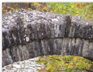
Σχέδιο 5Α. Τοποθέτηση των θολιτών λίθων.
