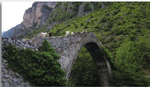
Εικόνα 01. Το μονότοξο γεφύρι της Κόνιτσας
