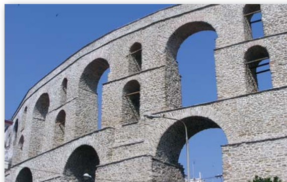
Εικ.10. Υδατογέφυρα στην Καβάλα.
