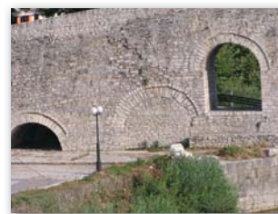
Σχέδιο 6Α. Κατασκευή ψευτοκαμάρας στην πλημμυρική κοίτη.
