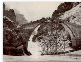
Σχέδιο 4Β. Στήριξη του «κρεμαστού» ξυλότυπου στις δοκοθήκες.
