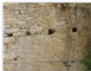
Σχέδιο 4Α. Κατασκευή δοκοθηκών στη γένεση του πέτρινου τόξου.
